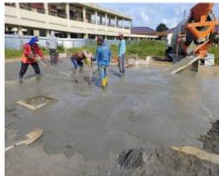
PENGECORAN LANTAI
